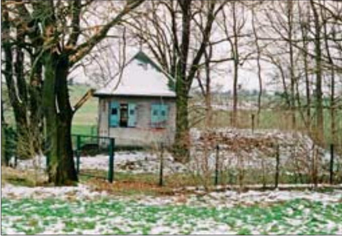
Wasserhebewerk der Gemeinde Gröna aus dem Jahre 1911/12 im Wiesengrund
