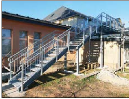
Der endlich „fast“ fertiggestellte 2. Rettungsweg
