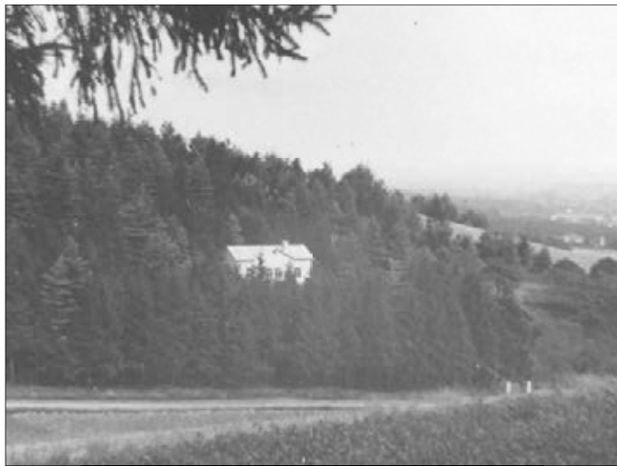
Unterkunftshütte in den 30er Jahren (Blick von Waldrand)
