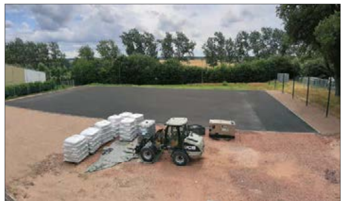
Aktueller Stand beim Bau des Sportplatzes am 15.07.2024
