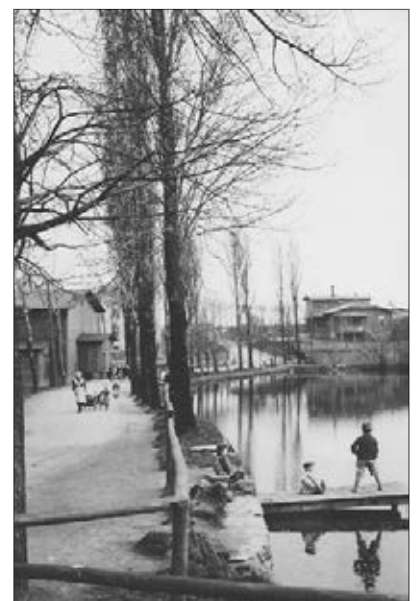
Ostufer des Wiesenmühlenteich an der Mittelbacher Straße, rechts das ehemalige Schützenhaus (ab 1897)
